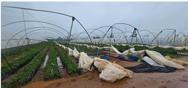
Figura 1. Invernaderos de fresa con daños estructurales y de cubierta
